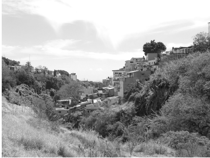
Figura 8: Puente Independencia 2000 (vista hacia el sur).
